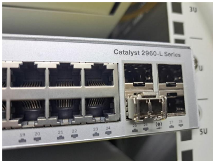
ภาพที่ 4.31 ติดตั้ง SFP Module
