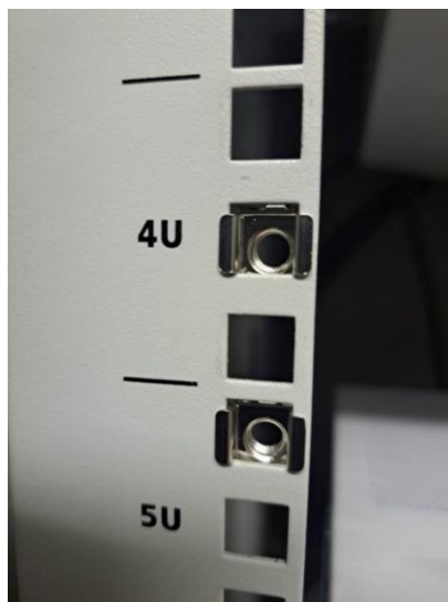
ภาพที่ 4.29 ติดตั้งน็อต Cage Nut
