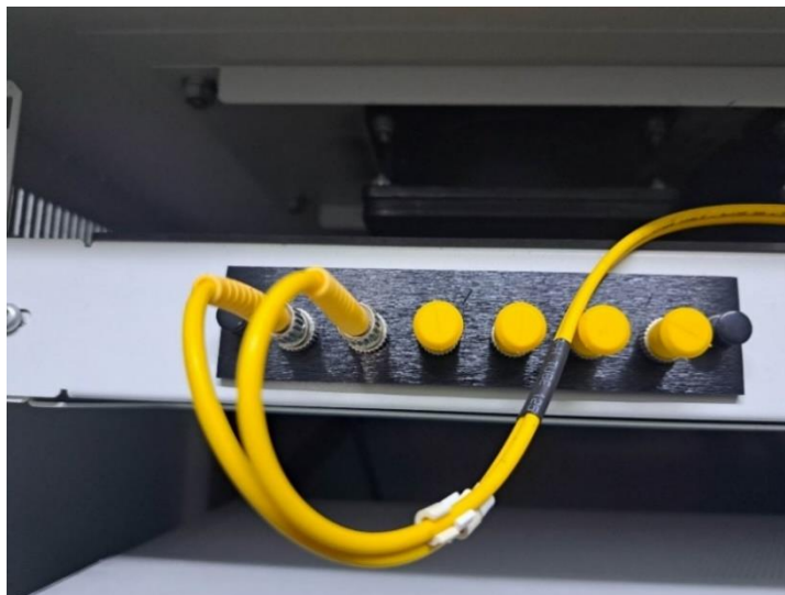
ภาพที่ 4.33 เชื่อมต่อสายสัญญาณ Patch Cord Fiber กับ Fiber Optic Patch Panel
